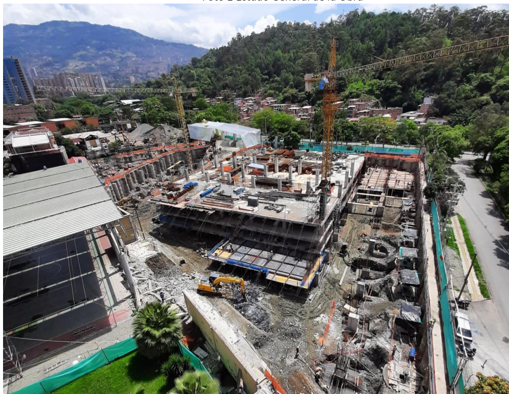
Foto 1 Estado General de la Obra
