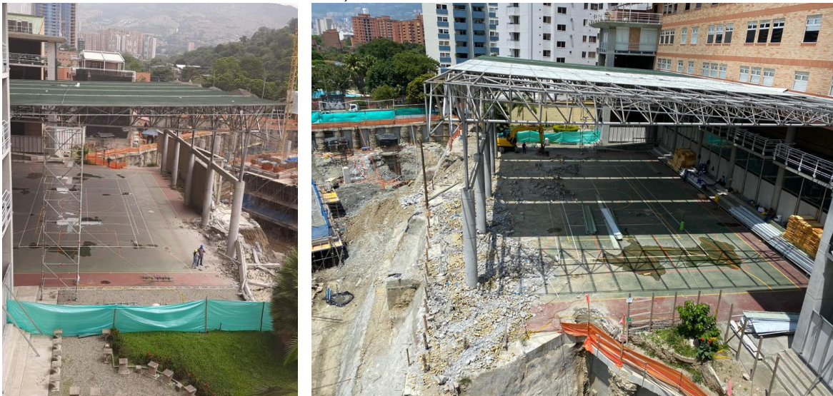
Fotos 2 y 3 Desmante de la cubierta de la cancha
