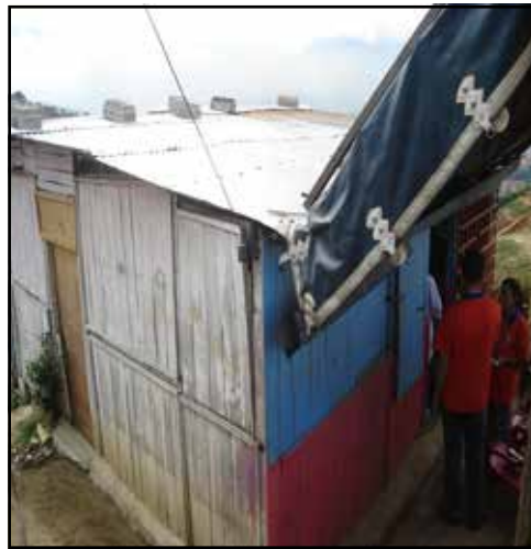
Fotos tomadas por integrantes LUES 2008. Características generales de las viviendas en el asentamiento Altos de la Virgen.
