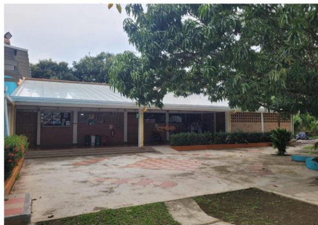
Ilustración 19. Intervención Zona verde y cubierta Apartadó
